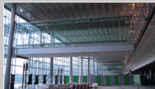
Peinture intumescente sur les poteaux de la salle d'embarquement.
